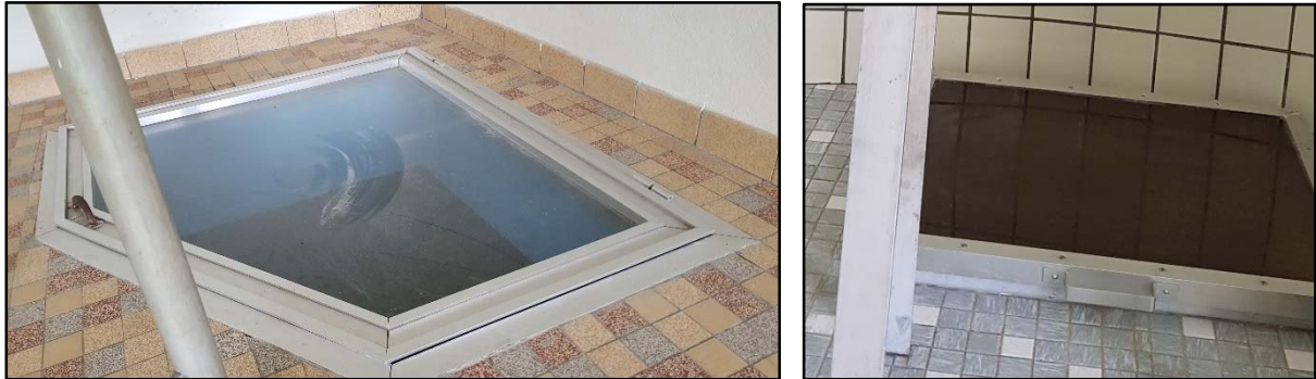
Abbildung 19: Zugang zu Wasserbehälter bei HB Saulach (links) und HB Breitenbronn (rechts)
