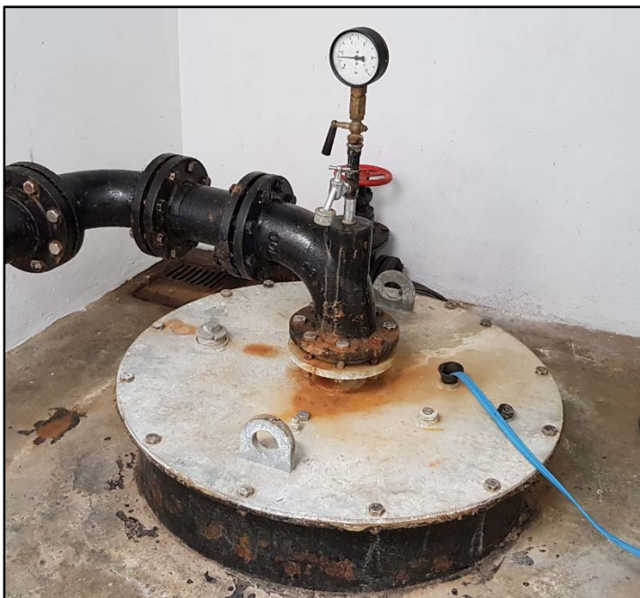
Abbildung 6: Öffnungen und undichte Stelle bei der Kabelführung am Brunnenkopf Brunnen I (linkes Bild) und Brunnenkopf von Brunnen II (rechtes Bild)
