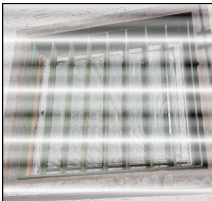
Abbildung 11: Fenster im „HB Saulach“ mit Insektenschutz (links); Belüftungsdome von HB „Breitenbronn“ insektensicher abgedichtet (rechts)
