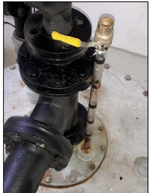
Abbildung 6: Öffnungen und undichte Stelle bei der Kabelführung am Brunnenkopf Brunnen I (linkes Bild) und Brunnenkopf von Brunnen II (rechtes Bild)
