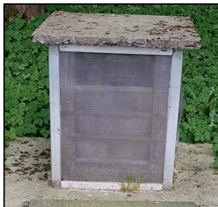
Abbildung 11: Fenster im „HB Saulach“ mit Insektenschutz (links); Belüftungsdome von HB „Breitenbronn“ insektensicher abgedichtet (rechts)
