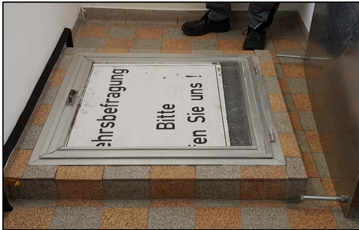
Abbildung 13: Einstiegs Luke des „Saugbehälters“ in der Aufbereitungsanlage Oberschöneberg
