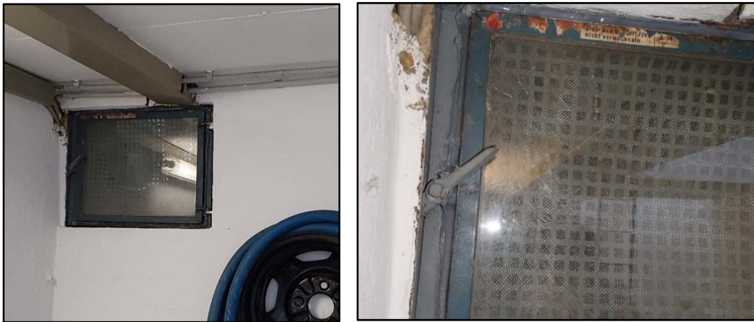
Abbildung 9: Fenster im Brunnenschacht von Tiefbrunnen III
