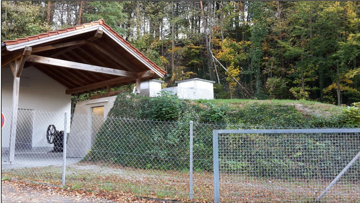
Abbildung 17: Behälterbewuchs bei „Hochbehälter alt“
