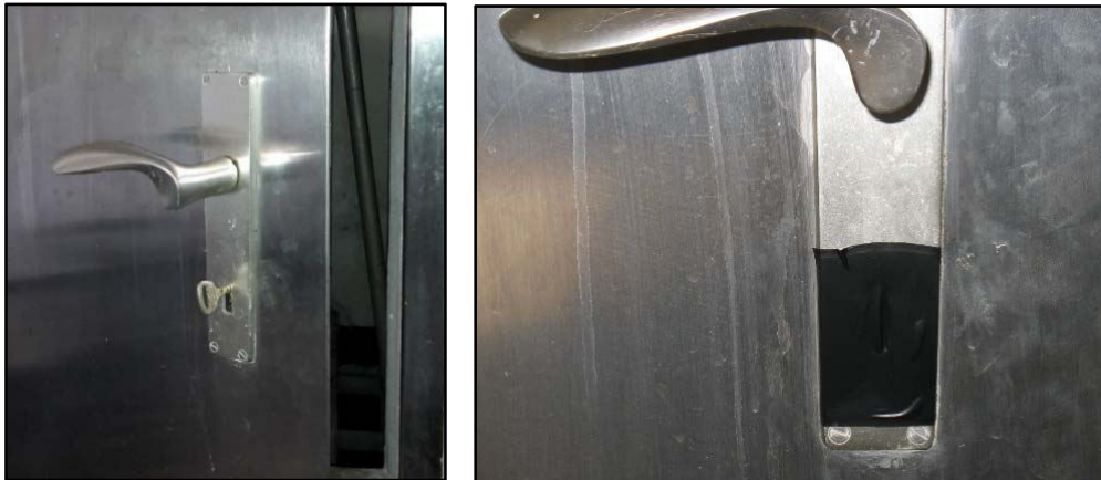
Abbildung 11: Türschloss von Tür in „Hochbehälter alt“ vor und nach der provisorischen Verschließung
