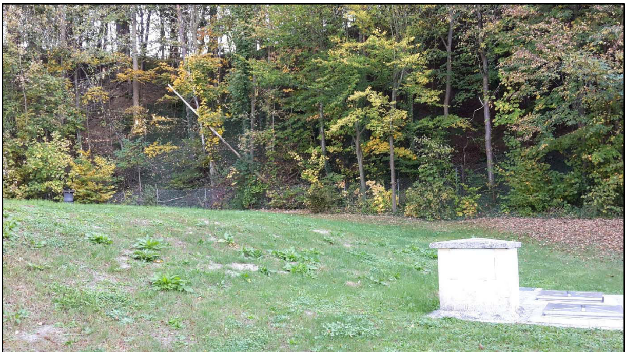
Abbildung 5: Bewuchs innerhalb des Fassungsgebietes von Tiefbrunnen III
