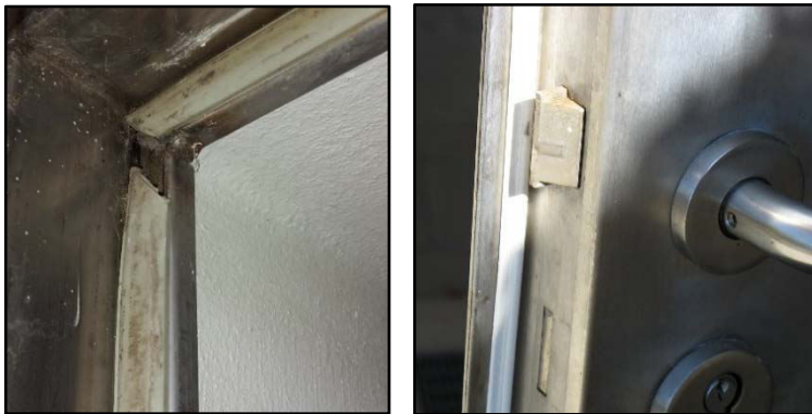
Abbildung 12: Türdichtung „Hochbehälter alt“ vor und nach der Erneuerung
