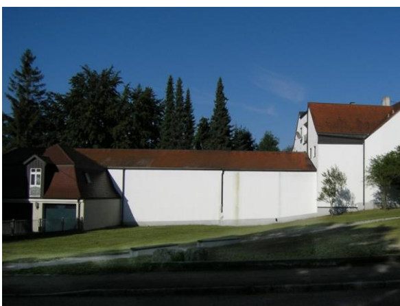
Abb. 72 Ist-Zustand der südlich gelegenen Freifläche
