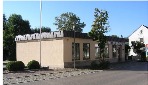
Abb. 41 untypisches Gebäude in der Bahnhofstraße
