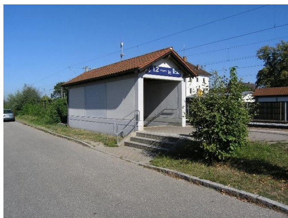
Abb. 68 Die Gleise sind überwiegend nur über steile Treppen erreichbar
