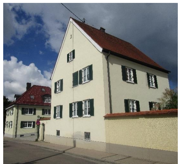
Abb. 53 Raumkante und hochwertig sanierte Gebäude in der Spitalgasse
