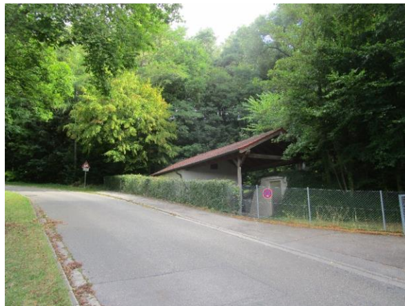
Abb. 84 Die Anbindung des Panoramabades für Fußgänger an die Burggasse sollte verlängert werden
