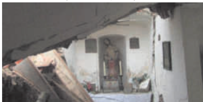
22.10.14: Die zerstörte Kapelle am Morgen nach dem Baumsturz
