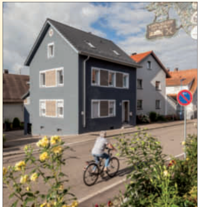
Gute Erfahrung mit Hanf-dämmung und ihren Vorteilen: Wolfgang (rechts) und Moritz Hornikel. Stilbildend: Die Optik des hanf-gedämmten Hauses in dunklem Anthrazit und Klinkern. Fotos: Caparol Farben Lacke Bautenschutz/akz-d
