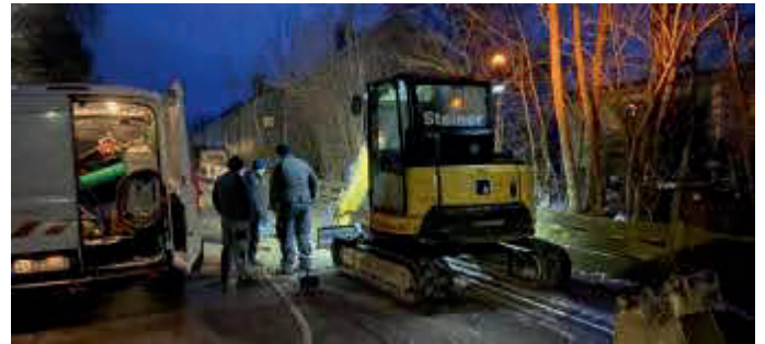
Reparatur eines Wasserrohrbruchs: schnelle Hilfe, sichere Versorgung
