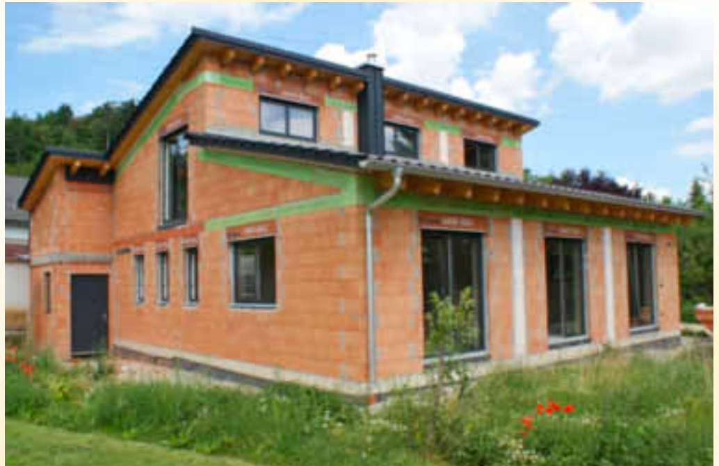
Ein Haus aus Ziegel und Holz bietet Bauherren das Beste aus zwei Welten: Der beständige Mauerziegel ummantelt eine natürliche, hochwärmedämmende Holzfaserausfüllung.
