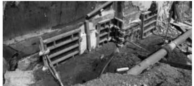
Für die Neugestaltung der Innenräume im Stadel wurden teilweise relativ neuzeitliche Mauern abgebaut, ein Fenster und eine Türe aus den 50er Jahren verschlossen, sowie ursprünglich vorhandene Fenster und Tore mit gemauerten Rundbögen freigelegt. Alle abgebauten Vollziegel werden geputzt und später wieder eingebaut.
