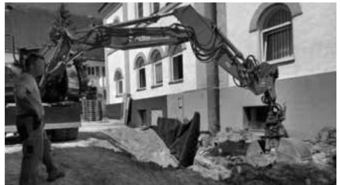
Nachdem schon der größte Teil der Außenwand des Kellers unter dem Rathaussaal freigelegt war, wurde das Fundament unterfangen und eine Feuchtigkeitssperre eingebaut.
