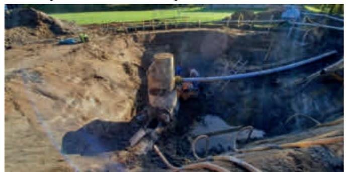
Nach einer provisorischen Reparatur 2021 wurde nun dieser Schacht und die Röhre in unmittelbarer Umgebung ersetzt. Für die Sanierung der weiteren Strecke entschied sich die Gemeinde für ein weitgehend grabenloses Verfahren. Dabei wird in das bestehende, geschwächte Rohr ein neues, dichtes Rohr eingezogen. Die Gesamtmaßnahme kostet ca. 500.000 €.
