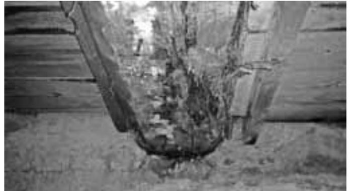
Anschließend wurde die Konstruktion mit einer Brettverschalung an der Kellerdecke abgedeckt und verputzt. Jahre später wurde dann von oben eine Glaswollisolierung eingebracht und Spanplatten für den Teppichboden verlegt.
