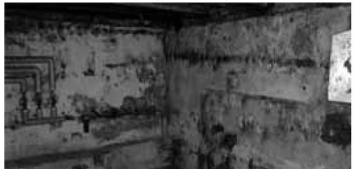
Das Büro darüber wurde zwar etwas trockener, Nebenwirkung jedoch: Die Feuchtigkeit im Keller nahm stark zu, teilweise bilden sich nach Regenfällen sogar Pfützen auf dem Boden.
