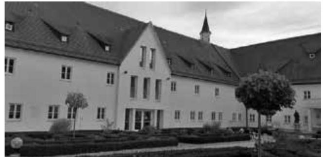
Durch die Baumaßnahme kann man nun direkt und barrierefrei vom Saal in den gemütlichen Innenhof der Anlage gehen oder auch rollen. Zudem wurde damit der Flur des Dachgeschosses deutlich aufgeweitet und hat eine deutlichen Zugewinn von Tageslicht zu verzeichnen. Alle Fenster wurden durch 3-fach Verglasung ersetzt und tragen dadurch zum Energiesparen bei.
