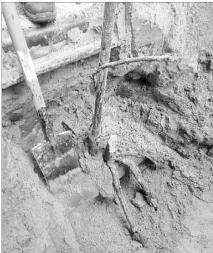
Abbildung 1: Trinkwasserleitung zw. Riegerweg und Kohlstattstraße von Wurzeln umschlungen.
