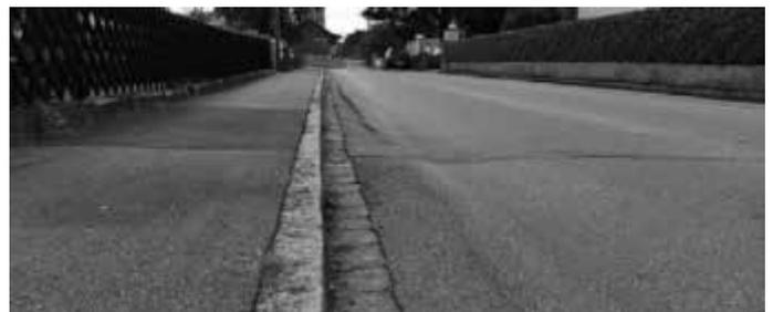
Dazu wird der bestehende Belag abgefräst und anschließend eine neue, schwerlastfähige Tragdeckschicht aufgebracht. Man rechnet mit Kosten von ca. 340.000 €. Ein grundhafter Ausbau würde mit rund 2,5 Mio. € zu Buche schlagen und wurde als derzeit nicht finanzierbar eingestuft.
