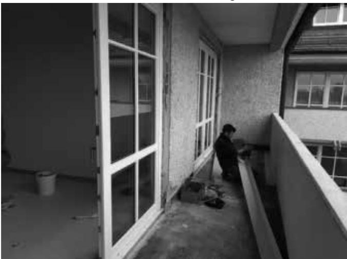
Anschließend wurden die Balkone abgedichtet. Im letzten Arbeitsschritt werden Split und darauf Pflaster für einen ebenerdigen Übergang verlegt.
