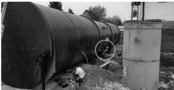
Der Betonschacht dient der ordnungsgemäßen Entleerung (z.B. nach der Reinigung) über Pumpen in den Schmutzwasserkanal.
