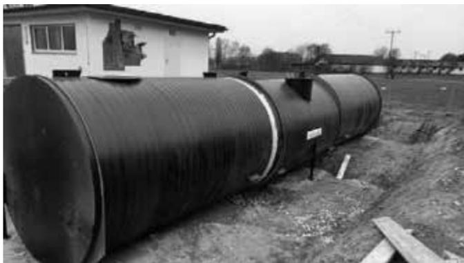
Links und rechts in der Anlage ist Platz für jeweils 50m<sup>3</sup> Wasser, in der Mitte, unter dem Einstiegsdom befindet sich die Anlagentechnik mit Steuerung und Pumpen.
