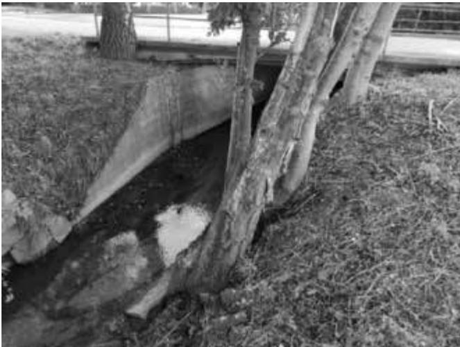
Bei Bauwerk Nr. 22 (Brücke über die Herrenroth im Zuge des Heuweges) ist die Aufkantung des Widerlagerflügels stark beschädigt. Der Bauhof wird die Brücke, soweit möglich, wieder in Stand setzen.
