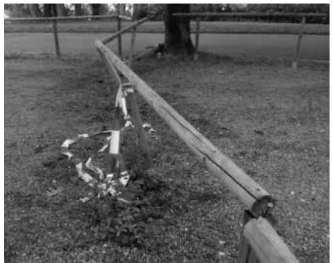
Demnach wird die Reparatur etwas aufwendig, da die einbetonierten Metallfüße umgebogen bzw. abgebrochen sind und ausgegraben werden müssen.
