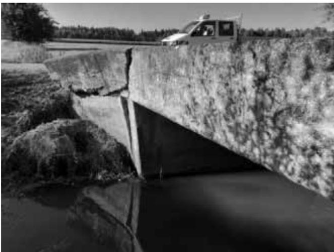
Bei Bauwerk Nr. 27 (Brücke über die Herrenroth am oberen Rohrmählerweg, südlich von Häder) ist das Gelände und die Brückenplatte schadhaft. Auch hier wird der Bauhof versuchen, das Gelände wieder in Ordnung zu bringen.
