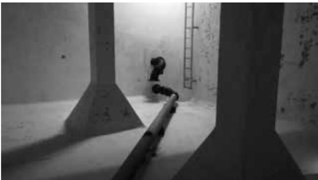
Letzte Woche hat nun die Oberflächensanierung begonnen. Mit dem Sandstrahlgerät werden zunächst von Boden, Decke und Wänden die schadhafte Beschichtung und der alte Putz entfernt. Gegebenenfalls werden Armierungsschäden behoben. Dann wird alles neu verputzt und beschichtet. Am Ende werden neue Edelstahlrohre und Durchlässe eingebaut. Die Innenarbeiten werden voraussichtlich 6 - 8 Wochen dauern.
