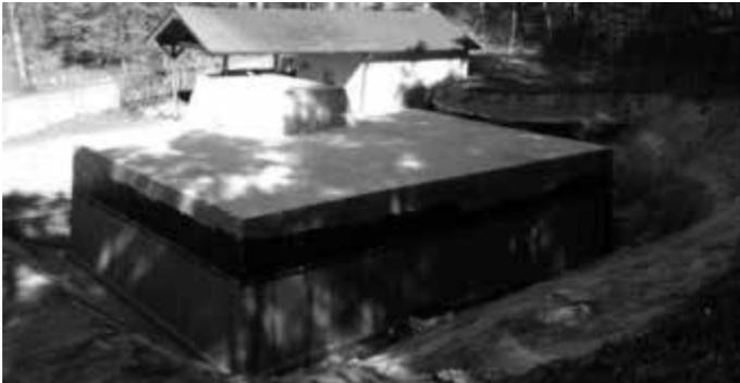
Anschließend wird auf der Decke des Behälters die Dämmung montiert. Dadurch wird eine Aufheizung des Wassers im Behälter durch Erwärmung des Erdreichs verhindert.
