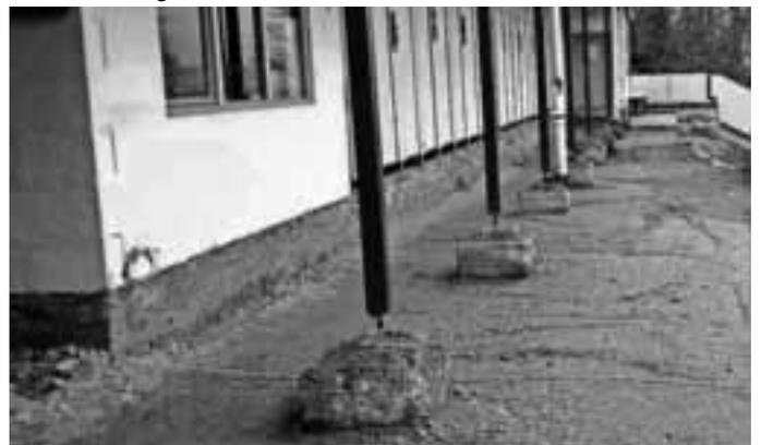
Eine Edelstahlschleife rund um das Gebäude unter dem neuen Pflaster, Ableiter vom Dach und eine Kabelverbindung zum Fundament des neuen Kinderbeckens bringen die gesamte Anlage auf den aktuellen Stand nach DIN EN 62305.
