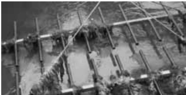
Bevor die Belüfterkerzen gewechselt werden konnten, mussten rund zwei Tonnen Feuchttücher entfernt werden. Diese werden bei starkem Regen durch die Schmutzrechen gedrückt.
