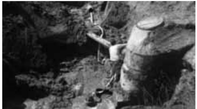
Das Loch wurde zunächst durch Bleche und Beton verschlossen. Im nächsten Schritt gilt es festzustellen wie weit und wie stark der Kanal geschädigt ist um dann ein Umleitungs- und Reparaturkonzept zu erarbeiten.
