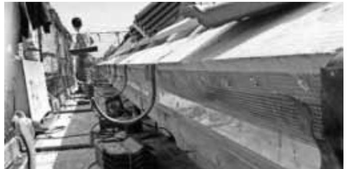
Marode Dachbalken wurden repariert, auf den Sparren wurde eine Isolierung montiert. Traufbleche und Dachrinnen wurden angepasst und teilweise erneuert. Abschließend wurde das Dach neu gedeckt.
