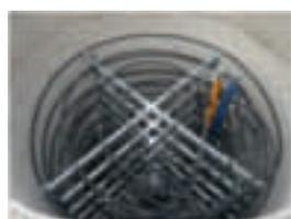
Bild 4: SolarEis-Speicher für die Wärmepumpenanlage eines Einfamilienhauses.
