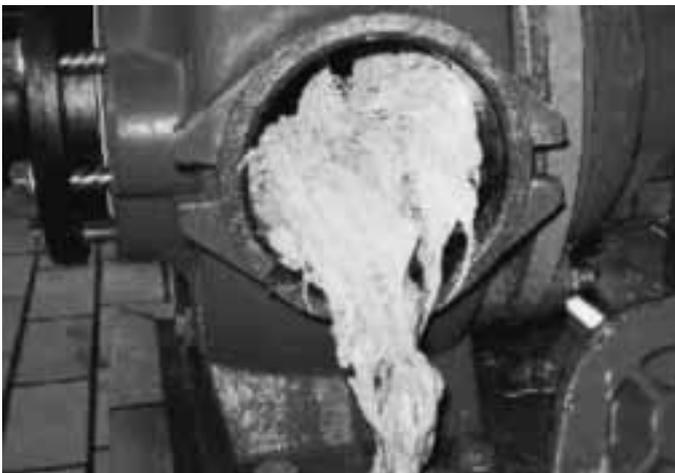
Die Pumpen müssen dann von den Mitarbeitern gereinigt werden, die dann die gepressten Stopfen aus den Pumpen ziehen, damit diese wieder laufen können. Auch nachts und am Wochenende, denn durch die Verzopfungen stellen sich die Motoren der Pumpen automatisch ab. Dann muss sofort gehandelt werden und für die Mitarbeiter fallen Überstunden an.
