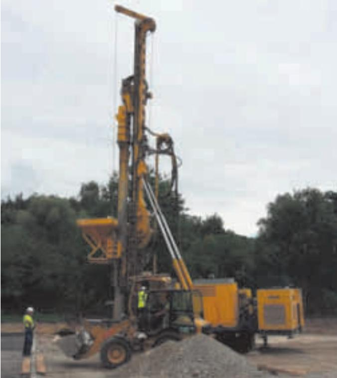
Dabei erfolgt zuerst durch den Rüttler ein Verdrängen des anstehenden Bodens. In den entstandenen Hohlraum wird durch etappenweises Ziehen des Rüttlers Kies eingefüllt und verdichtet. Es entsteht eine verdichtete, eng mit dem Boden verzahnte Säule.
