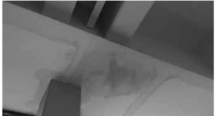
Man wurde schnell fündig: Die Dachentwässerung erfolgt nach innen und war bei den extremen Regenfällen nicht mehr voll aufnahmefähig. Das Überwasser verteilte sich auf einer Fläche von rund 800 m<sup>2</sup> zwischen ehemaligem Flachdach und dem darauf befindlichem Dämmmaterial.
