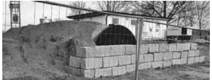
Im Falle eines äußerst unwahrscheinlichen Schadens am Behälter können die Steine zur Reparatur weggenommen und anschließend wieder aufgestellt werden.
