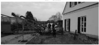
Dazu wurden ca. sieben Meter lange Stahlstangen unter das Gebäude getrieben und mit Beton vergossen.
