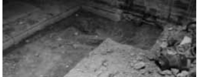
**Freibadgebäude:** Für die neuen Sanitäranlagen wurde der Fußboden im Kabinentrakt zersägt.
