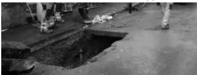
Ziemlich desolat scheint das Wasserrohr in der Burggasse zu sein. Mehrere Rohrbrüche in relativ kurzen Abständen lassen darauf schließen. Eine Komplettsanierung vom Marktplatz bis zum Wasserwerk muss in Erwägung gezogen werden.
