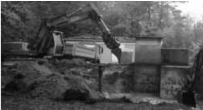
Nun können die Decke und die Wände des Behälters auch von außen einer fachmännischen Begutachtung unterzogen werden. Anschließend ist zu entscheiden ob es Sinn macht den Behälter zu sanieren, oder ob ein Ersatz geplant werden muss.
