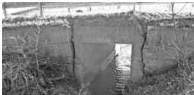
Die Gemeindeverbindungsstraße von Dinkelscherben nach Ustersbach quert nach ca. 2,2 km den Aufraben. Dieser wird durch einen betonierten Durchlass von der einen Seite der Straße auf die andere geführt. Das Bauwerk wurde zum Teil unterschwemmt und auch die Stützmauern auf beiden Seiten der Straße sind abgebrochen. Mit einem Wellblechdurchlass, wie am selben Graben unter der Straße nach Ried, soll das Problem behoben werden - Haushaltsmittel: 60.000 Euro.
