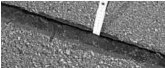
Es muss, soweit wie möglich, verhindert werden, dass durch die Risse Wasser eindringt und dadurch der Boden unter der Asphaltdecke im nächsten Winter gefriert. Dadurch würden die Schäden größer und es käme zu Absenkungen oder Anhebungen.
