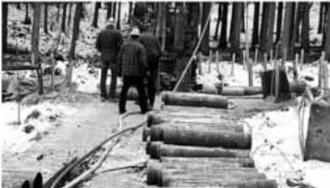
Die Inhalte der Meterstücke aus dem Bohrloch werden in Holzkisten gelagert und anschließend vom Geologen untersucht. Es wird die Lage der Grundwasserleiter, der Sperschichten und die voraussichtliche Ergiebigkeit eines Brunnens an dieser Stelle ermittelt.
