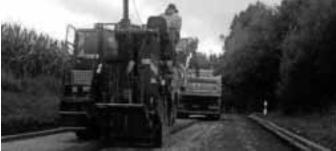
Dann wurde eine 10 cm starke Tragdeckschicht aufgebracht.
