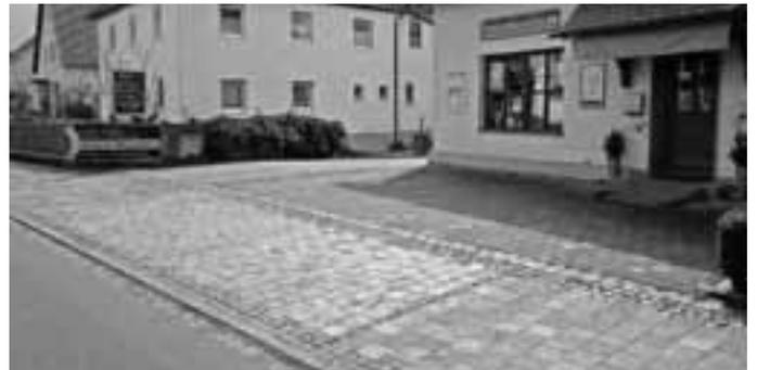
In der Kohlstattstraße wurden Lindenbäume gepflanzt, deren flache und üppige Wurzelwerke den Asphalt des Gehwegs anheben. Die schadhafte Stellen werden nun durch Pflaster ersetzt. Die lose verlegten Steine können dann bei erneuten Hebungen wieder ausgerichtet werden.
