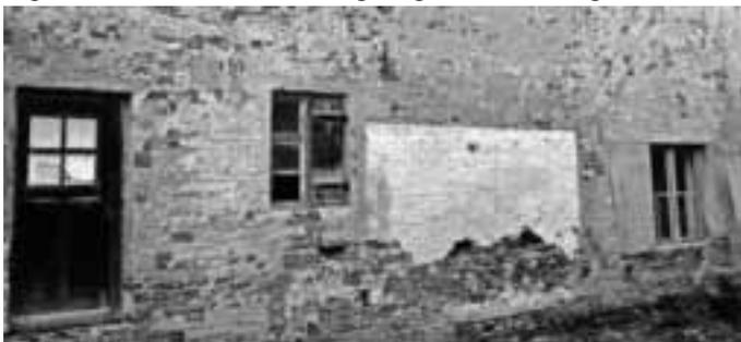
Nach dem Verputzen der Wand wird das Fundament vor Feuchtigkeit geschützt. Die Spezialisten rieten dazu, den Platz vor der Wand mit leichtem Gefälle zu pflastern, darauf das Regenwasser in einen Sinkkasten mit Kanalanschluss abzuleiten und so den Boden vor der Stadelwand möglichst trocken zu halten.
